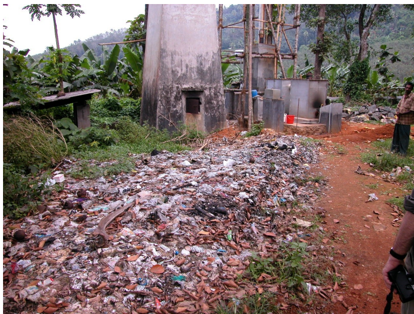
Fig. 1: From left: the old waste bunker, the old furnace and the new furnace 1. ábra: Balról: a régi hulladék raktár, a régi kemence és az új kemence
