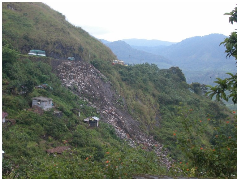
Fig. 7 and 8: Waste prepared to be removed by the Monsoon 7., 8. ábra. A monszonnal való eltávolításra előkészített hulladék
